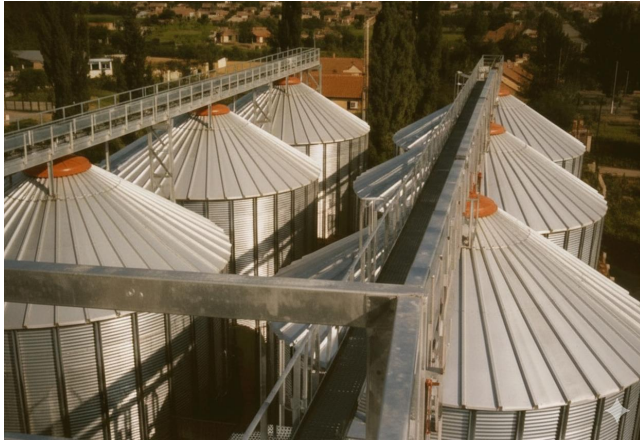
Рисунок 2.3 – Силосні корпуси з оцинкованої сталі.
