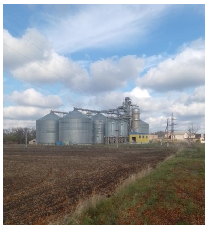
Рисунок 2.2 – Силосні споруди з плоским бетонним дном.
