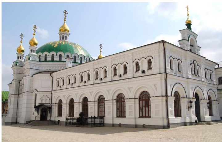
Рис. 2.2.6 Трапезна церква, за [51]
